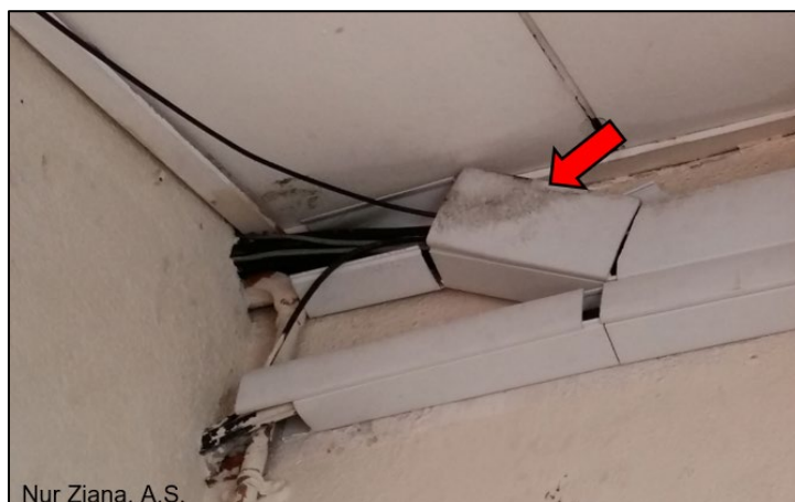
Gambarajah 5.5. Tanda palitan pada siling
