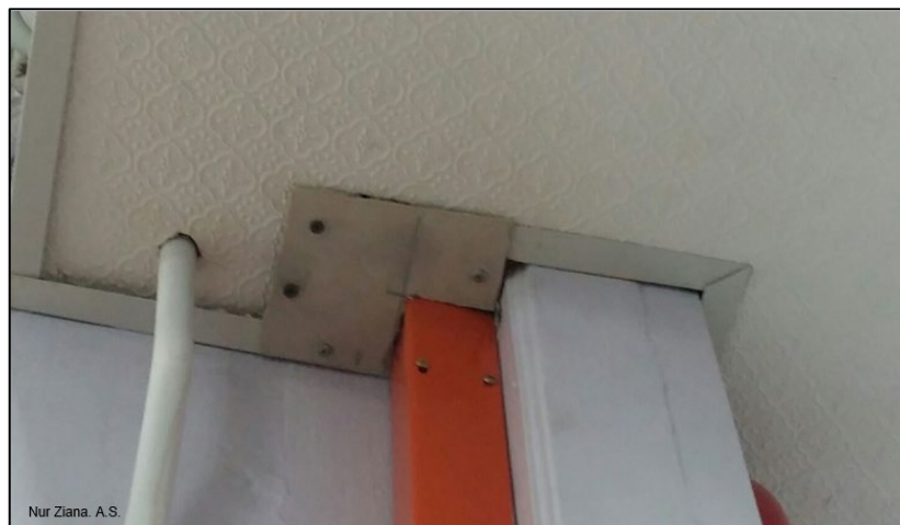
Gambarajah 5.14. Lubang akses tikus pada siling ditutup dengan kepingan asbestos
