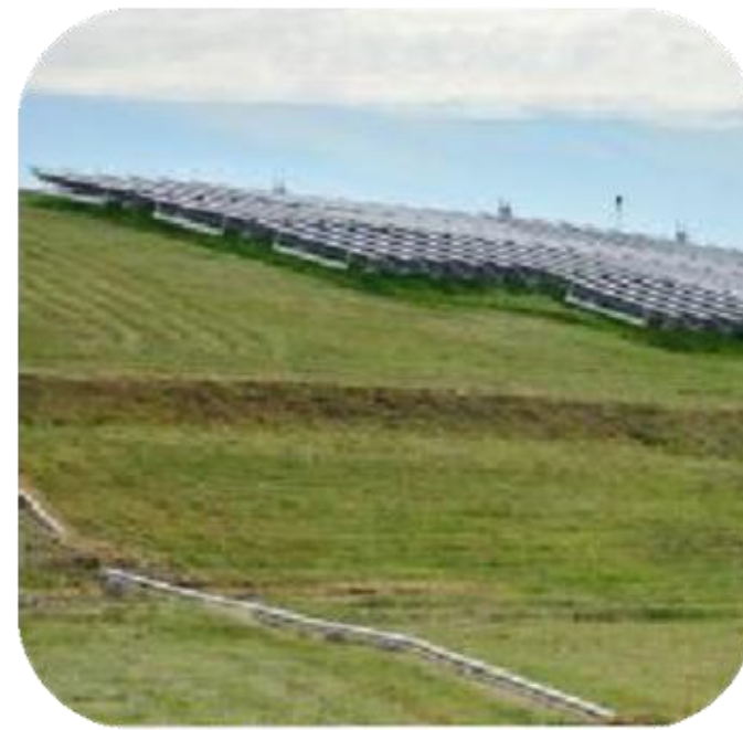
Penutupan Selamat Tapak Pelupusan
